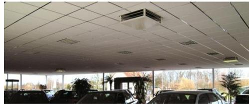
L'installation au plafond doit être également horizontale afin d'éviter l'air dans les différents raccords d'eau. L'aérotherme eau chaude doit être placé à une hauteur suffisante pour éviter toute projection d'air chaud direct. L'utilisation éventuelle de diffuseurs d'air (4 ou 6 côtés) peut s'avérer nécessaire pour une bonne distribution d'air.
