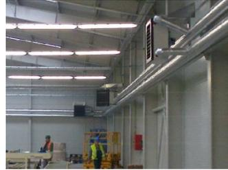
L'installation murale doit être horizontale afin d'éviter l'air dans les différents raccords d'eau. Cependant, l'aérotherme eau chaude peut être incliné vers le bas en s'assurant que le retour de l'eau soit dans la position la plus basse. Placez un dispositif de purge près de l'appareil. Utilisez éventuellement des volets verticaux pour une bonne distribution de l'air.
